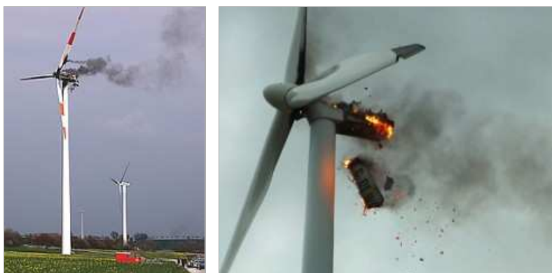
Obr. 1 Následky zásahu větrných elektráren bleskem
