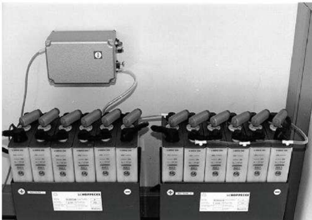
Obr. 10.19: Olověné akumulátory v reálné aplikaci [10]
