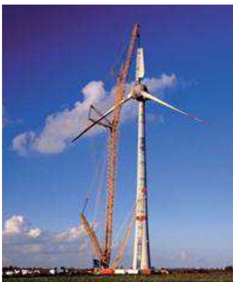
Montáž dělených rotorových listů - Enercon E126
