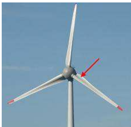
Rotor elektrárny. Červená šipka označuje část listu, která je odnímatelným spoilerem.
