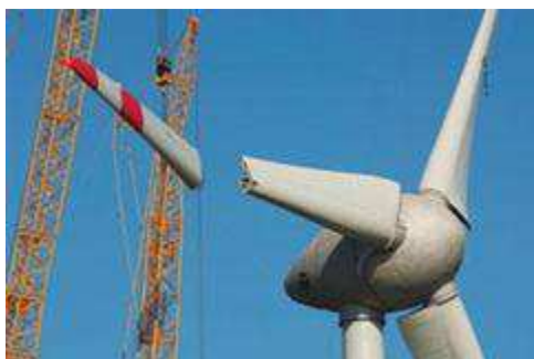
Montáž vnější poloviny rotorového listu - Enercon E126
