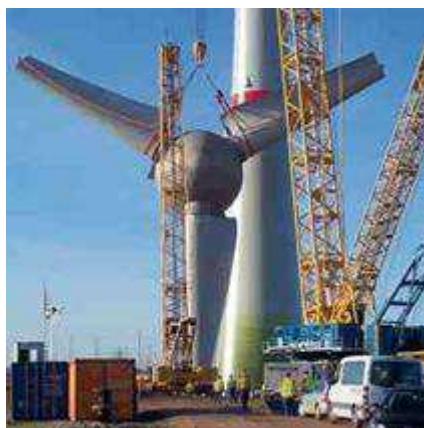
Rotorová hlava s kořenovými polovinami rotorových listů
