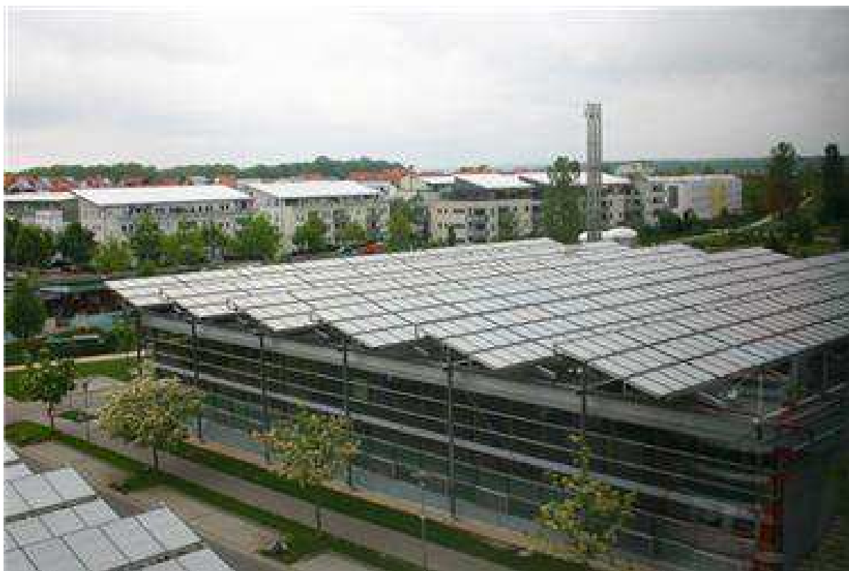
Velké kolektorové pole solárního systému se sezóní akumulací tepla v sídlišti Amorbach ve městě Neckarsulm v Německu
