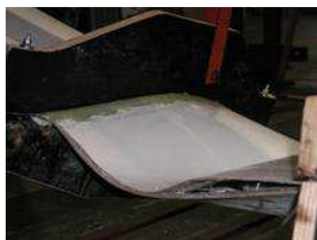
Delaminace odtokové hrany rotorového listu.
