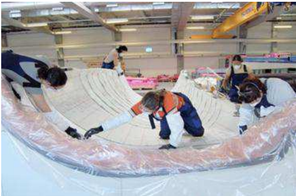
Výroba rotorového listu ve firmě Enercon. Je pěkně vidět, jak musí být tkanina rozdělena na mnoho dílů, aby se mohla vložit do tvarově náročné formy.
