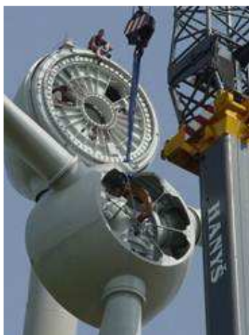
Snímky z montáže elektrárny z mnohapólovým generátorem. Na čele strojovny je vidět statorový prstenec generátoru a na zvedaném rotoru je v rotorové hlavě umístěn rotorový prstenec generátoru.
