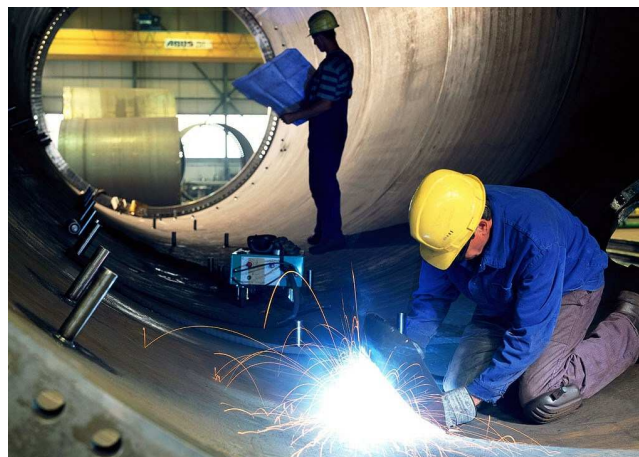
„Dovybavení“ segmentu stožáru úchyty pro jeho budoucí vnitřní technologie
