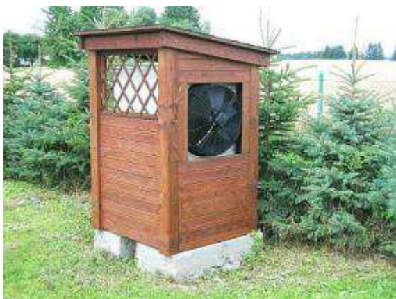
Tepelné čerpadlo vzduch/voda (Foto Kostečka Group spol. s r.o.)
