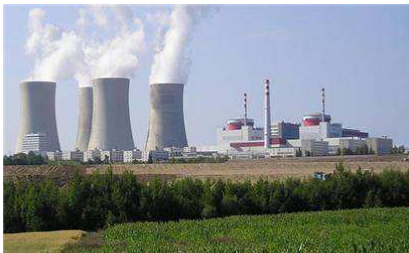
Jaderná elektrárna Temelín
