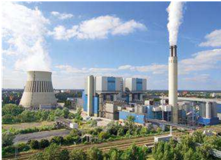
Tepelná elektrárna Reuter West 2x300 MWe v Berlíně (Siemensstadt) Zdroj: Vattenfall AG
