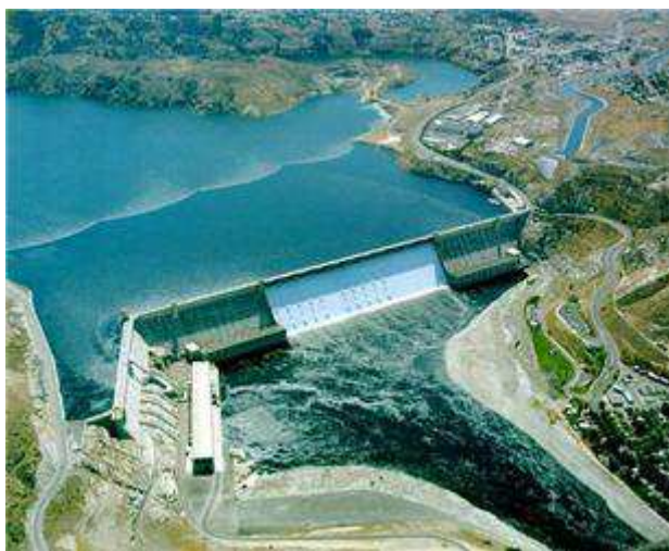
Vodní elektrárna Grand Coulee Dam 6809 MWe, (stát Washington, USA) Zdroj: Wikipedia (DE)
