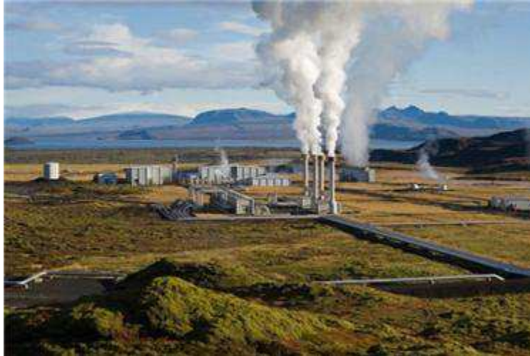
Geotermální elektrárna Nesjavellir (Island) o výkonu 4x30 MWe + 300 MWt Zdroj: Encyklopedie Wikipedia (EN)
