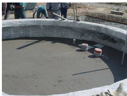
Pohled dovnitř vybetonovaného fundamentu
