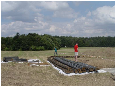
40 tun armovacího železa připravených k použití Okolo budoucího betonového základu se musí vztyčit bednění Detail uzemnění základu dostatečně dimenzovaného
