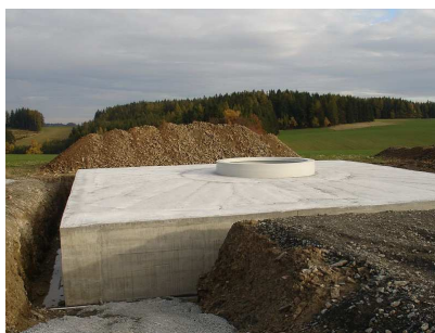
Celkový pohled na hotový železobetonový základ větrné elektrárny
