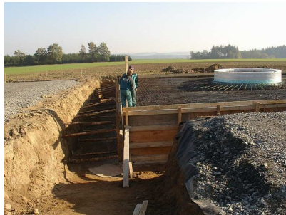
40 tun armovacího železa připravených k použití Okolo budoucího betonového základu se musí vztyčit bednění Detail uzemnění základu dostatečně dimenzovaného
