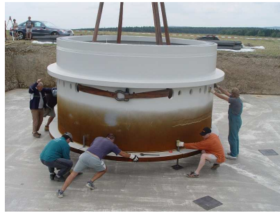
Přesné usazení fundamentu na určené místo Fundament před zahájením armování
