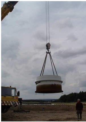
Přesné usazení fundamentu na určené místo Fundament před zahájením armování
