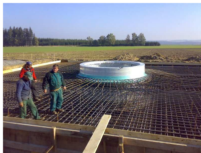
Pohled do útroby armování základu Pracovní prostředí lze občas přirovnat k pochůzce eskamotérů Celková armovací výztuž betonového základu
