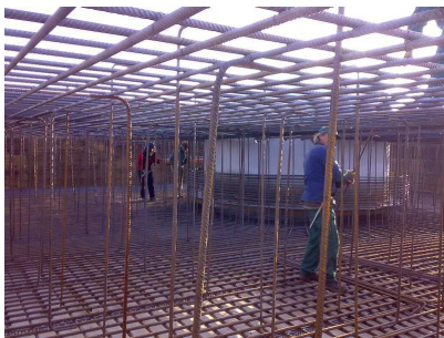
Pohled do útroby armování základu Pracovní prostředí lze občas přirovnat k pochůzce eskamotérů Celková armovací výztuž betonového základu
