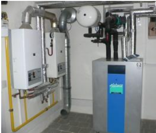
Kotelna s tepelným čerpadlem a plynovými kotli jako bivalentním zdrojem tepla
