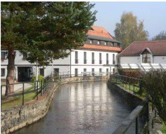
Rekreační objekt vytápěný tepelným čerpadlem, které ochlazuje říční vodu v náhonu malé vodní elektrárny
