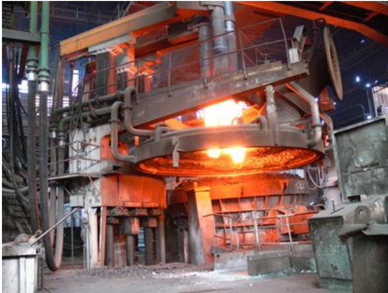
Elektrická oblouková pec 25 t v ocelárně Poldi Hütte, Kladno. Grafitové elektrody a klenba pece
