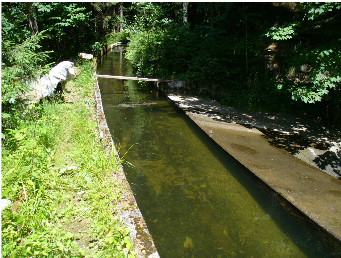
Obr. 19 Vodní náhon v betonovém korytě měří několik stovek metrů
