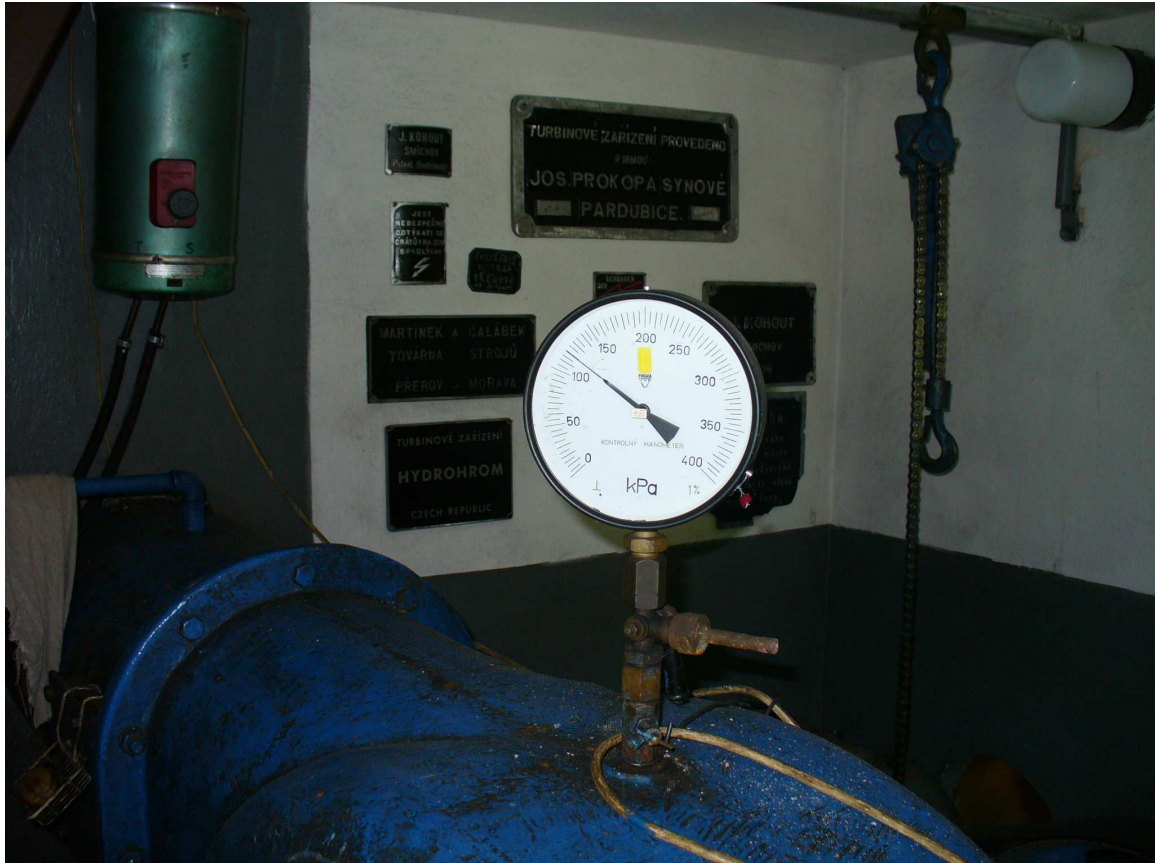
Obr. 14 Měřič tlaku na Francisově turbíně ukazuje 120 kPa
