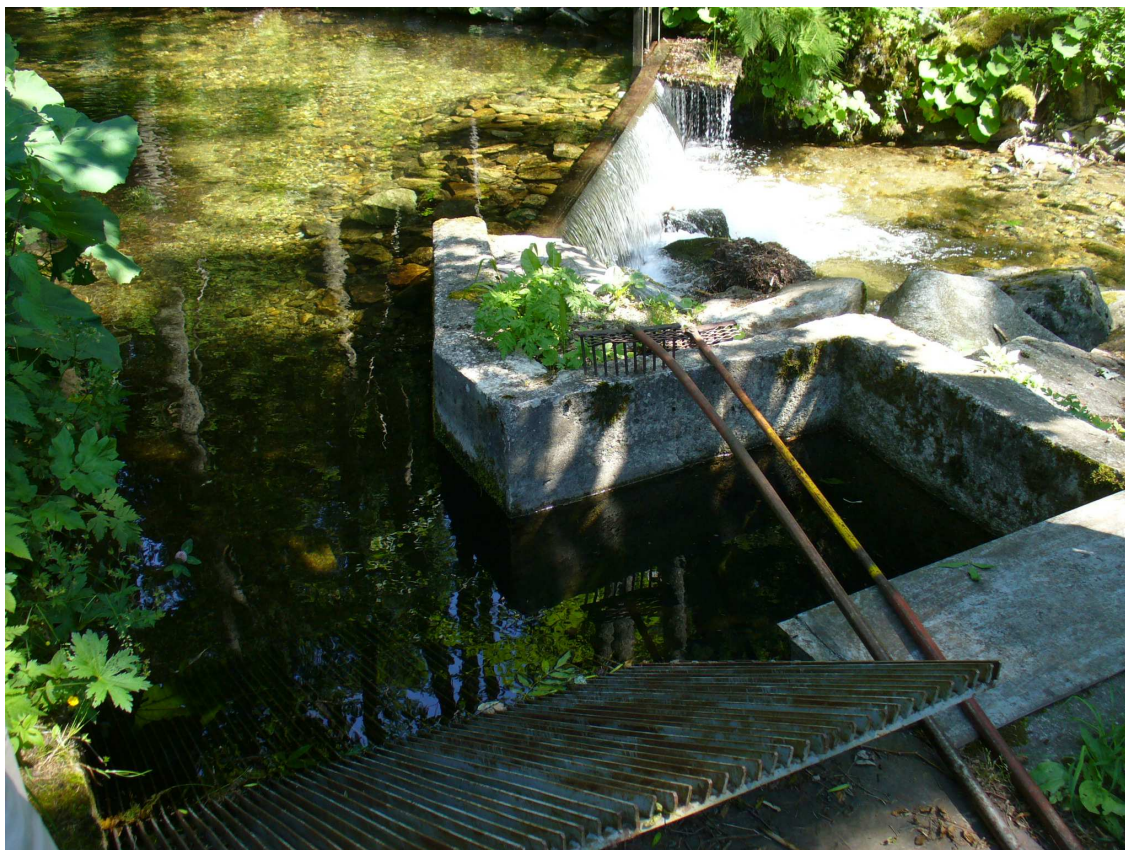
Obr. 9 Malý jez vpravo a česle s čistícím nářadím vlevo
