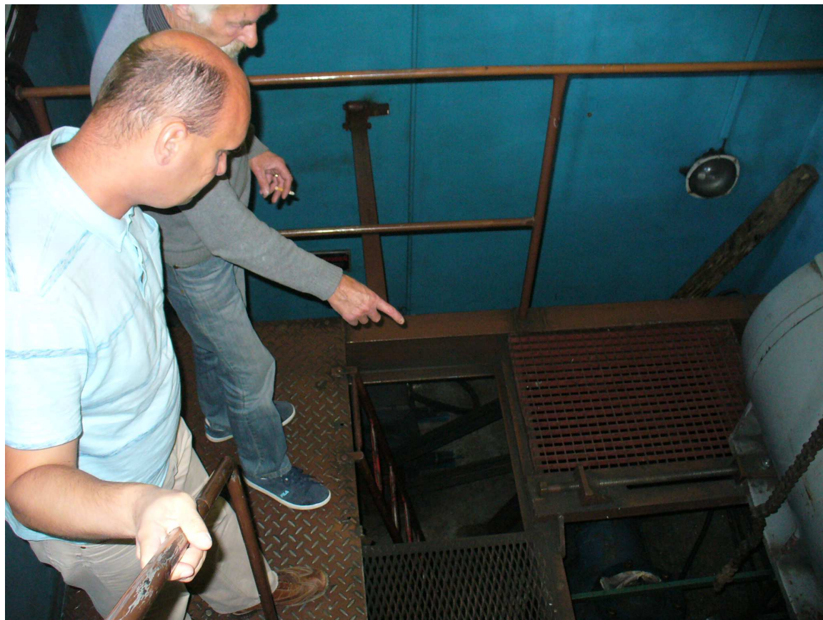
Obr. 16 Pohled do spodního patra strojovny, kde se roztáčí lopatky turbíny vodou
