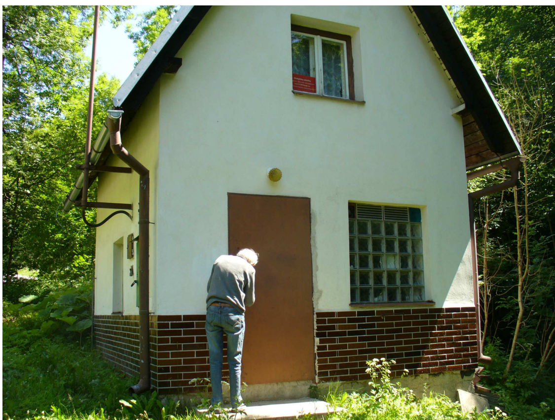
Obr. 10 Typická stavba určená pro malé vodní elektrárny
