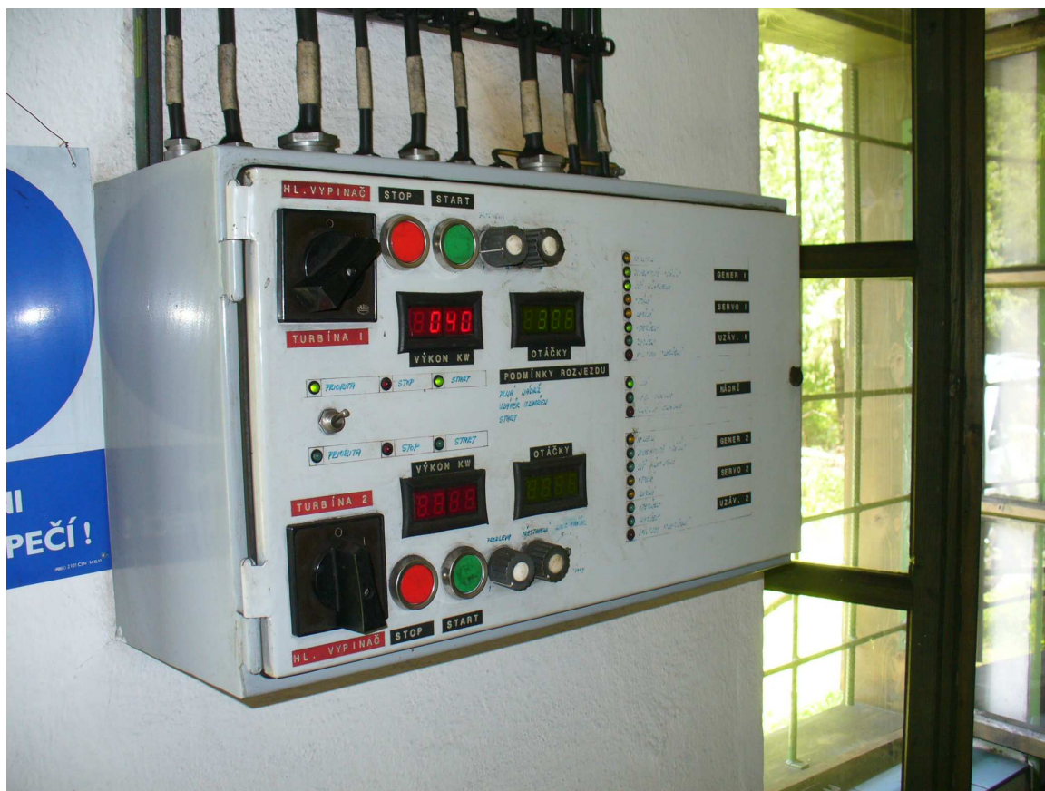
Obr. 15 Hlavní ovládací skříň ke spuštění turbín a sledování výkonu a otáček
