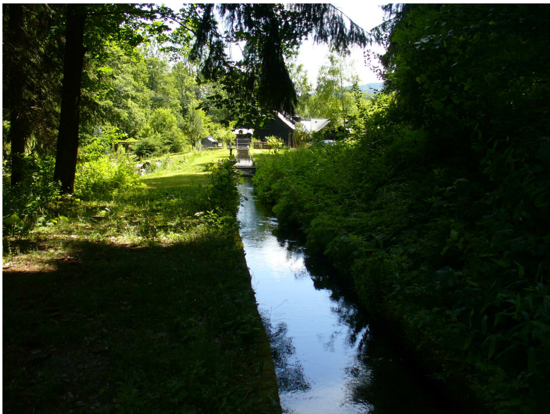
Obr. 8 Náhon k pohánění turbíny, uměle vybudovaný podél potoka
