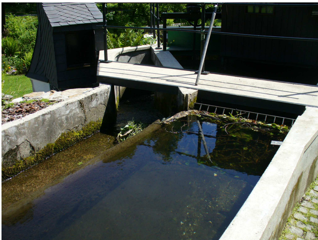
Obr. 2 Česle na konci náhonu zachycují hrubé nečistoty
