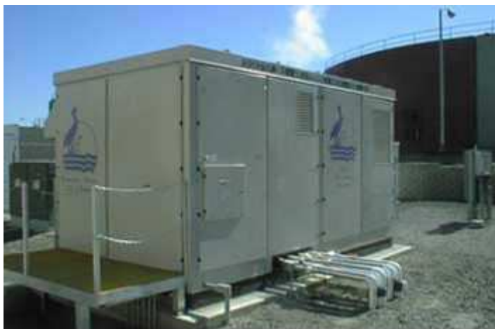
Obr. 8.38 . 200kW jednotka PC25 [61]
