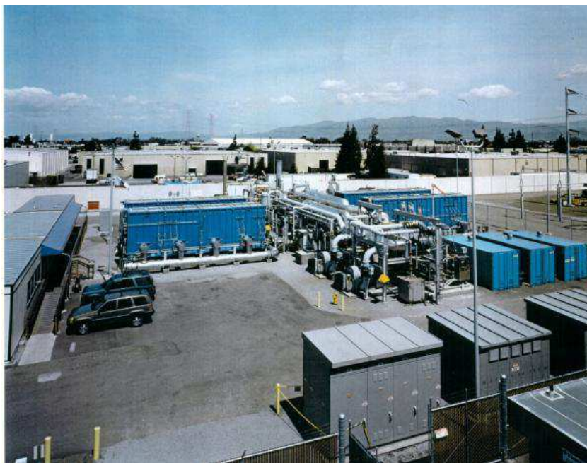
obr.8.26 Palivový článek o výkonu 2 MW instalovaný v Santa Claře v Kalifornii
