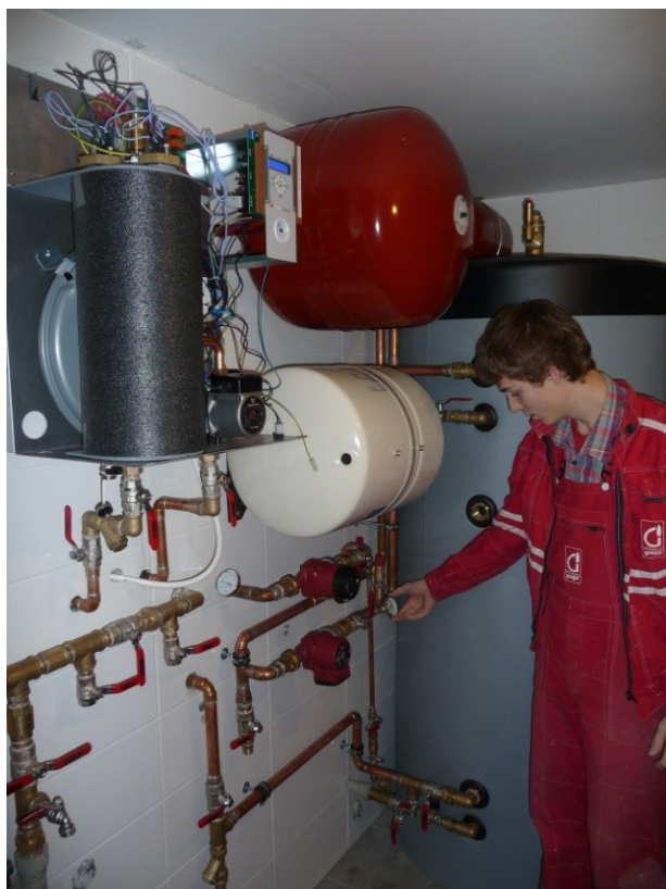
Obr. 4: Instalace zařízení během odborné praxe
