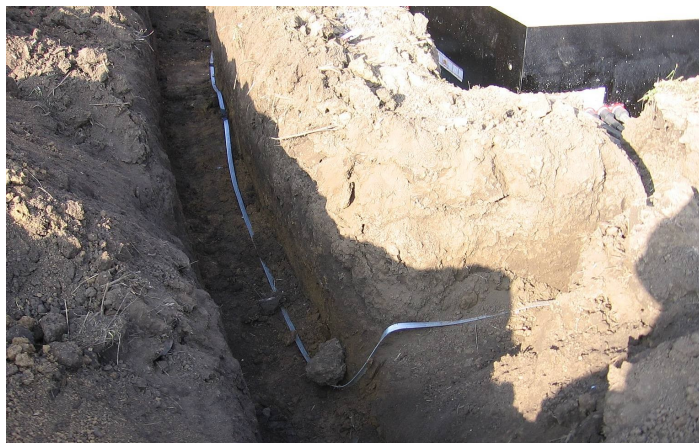
obr. Skutečné provedení zemnění
