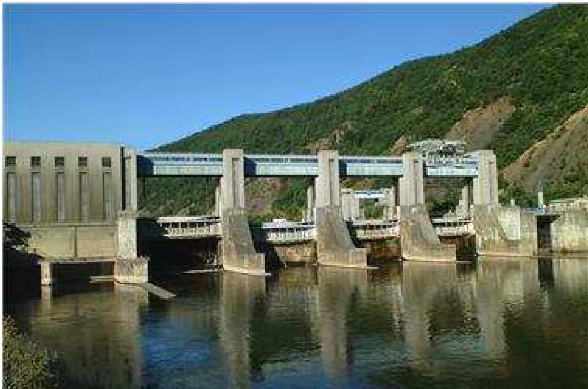
Vodní elektrárna Vrané. Zdroj: ČEZ
