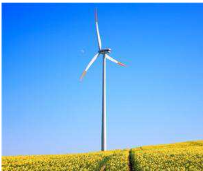
Počet větrných elektráren v ČR roste
