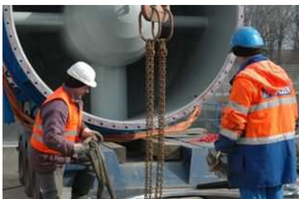
obr.7.14 Usazování turbíny malé vodní elektrárny Mělník
