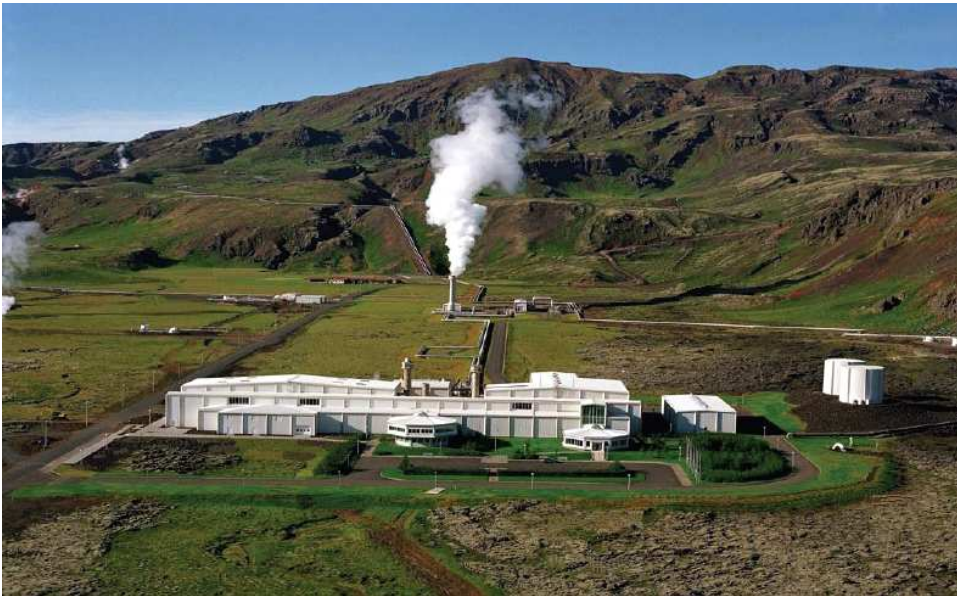
Obr. 5.14: Fotografie komplexu elektrárny [1]
