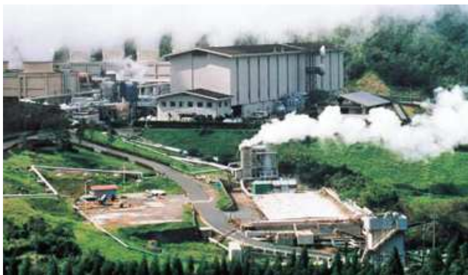
Obr. 5.13: První elektrárna na principu „double flash“ [6]
