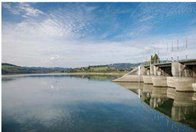
Přečerpávací nádrže mohou být řešením, jak uchovat energii. Zdroj: Thinkstockphoto.com
