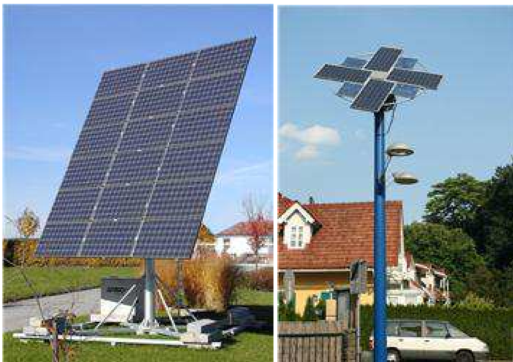
Některé fotovoltaické moduly se dokáží natáčet v osách pro dosažení maximální sluneční energie
