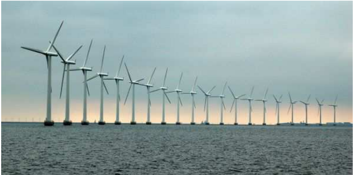
Tisícovka turbín a jejich úložišť by mohla krátkodobě nahradit kapacitu jedné jaderné či uhelné elektrárny. (Foto: sxc.hu)
