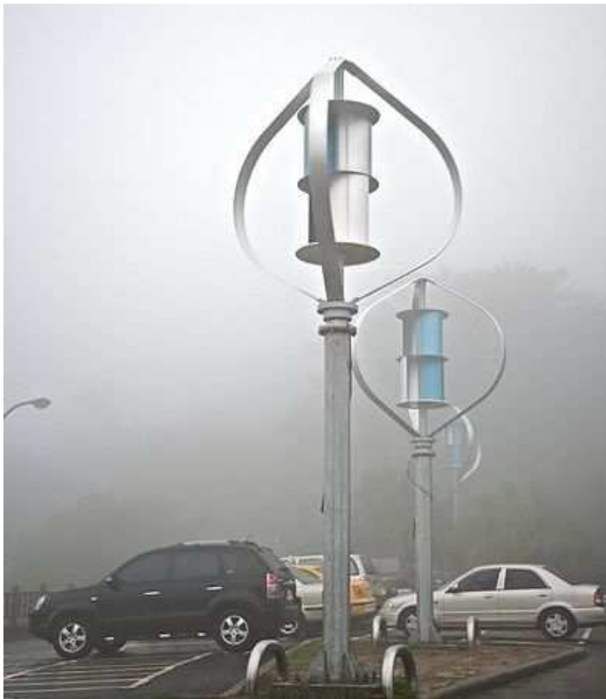
Savoniova turbína zajistí náběh pro Darrierův rotor. (Foto: Wikipedia, autor Fred Hsu)
