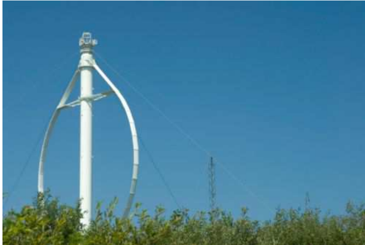
Nejjednodušší varianta Darrierova rotoru. (Foto: Thinkstockphotos.com)
