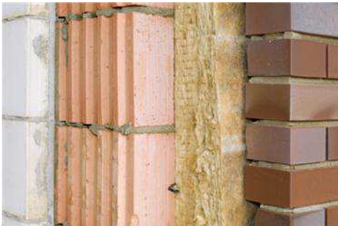
Tepelné čerpadlo se nejvíce hodí pro domy s kvalitním zateplením
