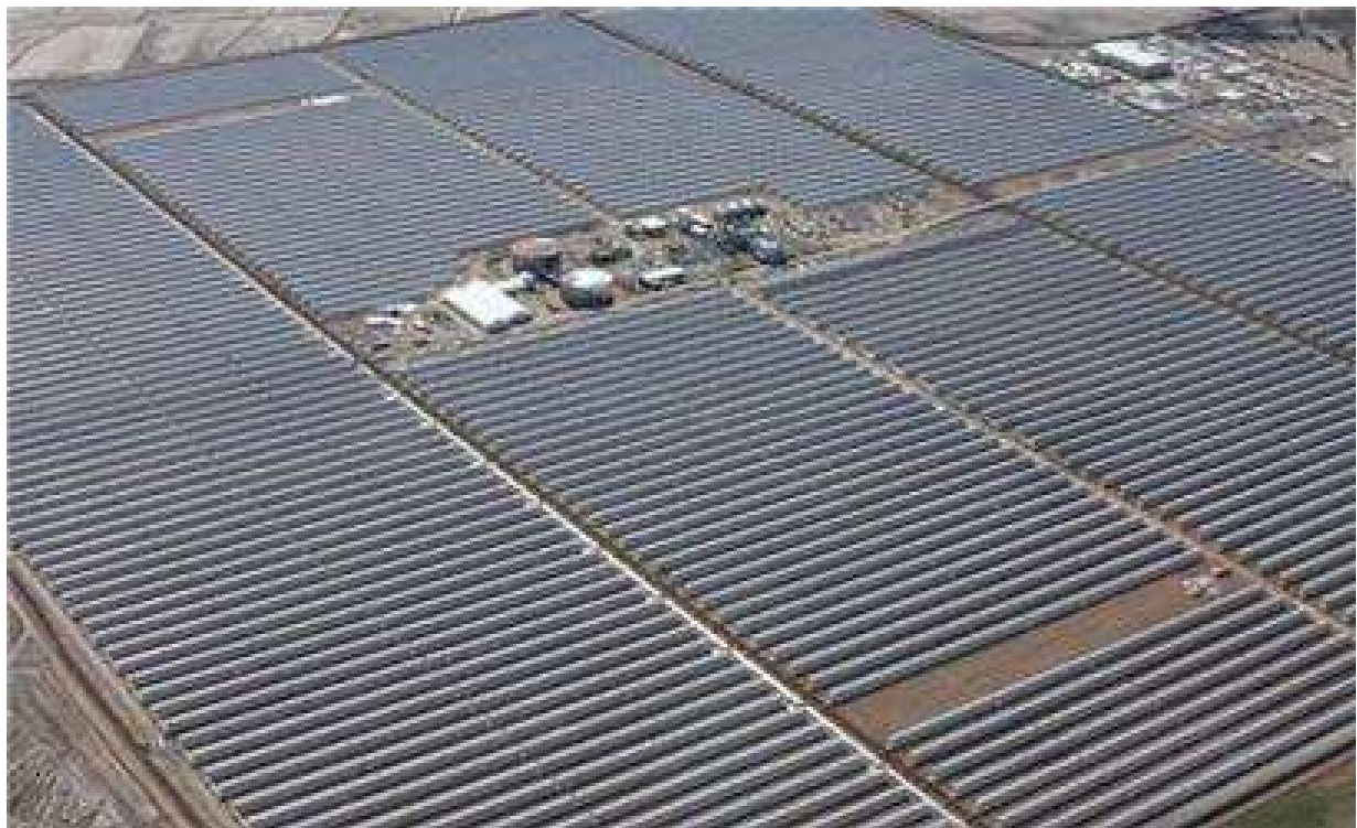
Elektrárna Andasol 1 v závěrečné fázi výstavby (jaro 2008). Zdroj: Solar Millennium AG
