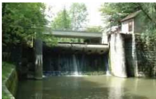
Malá vodní elektrárna (Rakousko). Foto: EkoWATT
