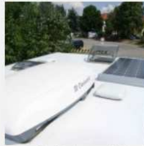
Umístění na střeše
