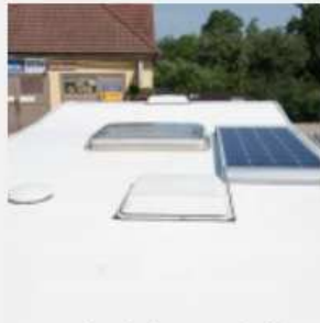
Umístění na střeše
