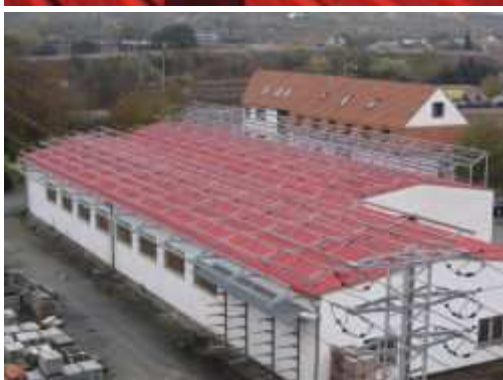
Střešní konstrukce na fotovoltaiky
