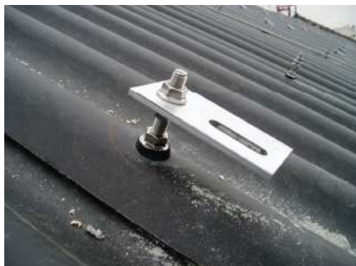
Obr. 3.27: Možné varianty uchycení panelů na sedlové střeše [15], [2]
