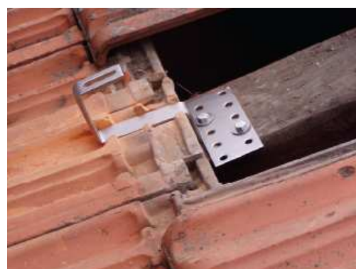
Obr. 3.27: Možné varianty uchycení panelů na sedlové střeše [15], [2]
