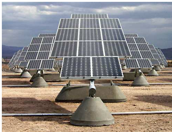
Obr. 3.29: Polohovatelný systém pro uložení panelů [15]
